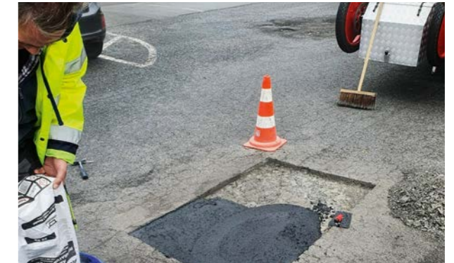
Sanierung Parkplatz mit ASPHALT REPAIR MIX
