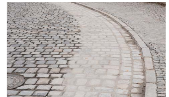
Barrierefreie Pflastersanierung in Amberg mit MORTAR MIX
