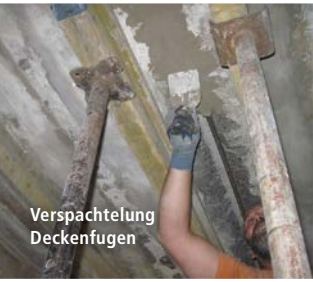
Flüssigkeitsdichte Tankstellensanierung
