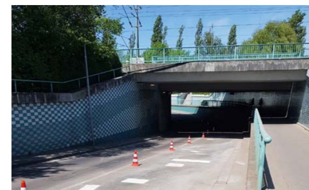
Ausbesserung einer Betonfahrbahn in Frankfurt mit CONCRETE MIX
