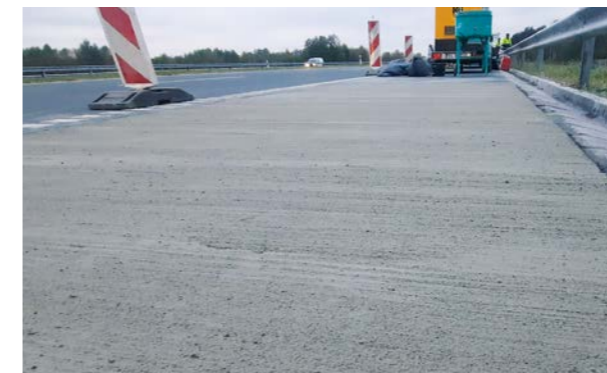
Sanierung eines Standstreifens einer vielbefahrenen Transitstrecke in Polen mit MORTAR MIX
